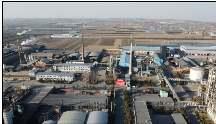
北侧德信隆化工有限公司
